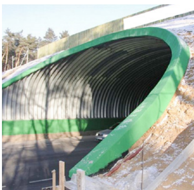
Wieniec żelbetowy – konstrukcja zakończona zgodnie z pochyleniem do skarpy.
