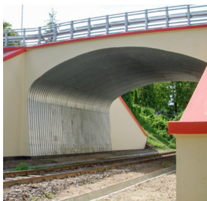
Ściana czołowa żelbetowa – konstrukcja ścięta pionowo.
