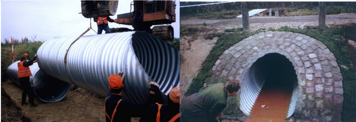
Fot. 13. Budowa przepustu z rur HelCor.
