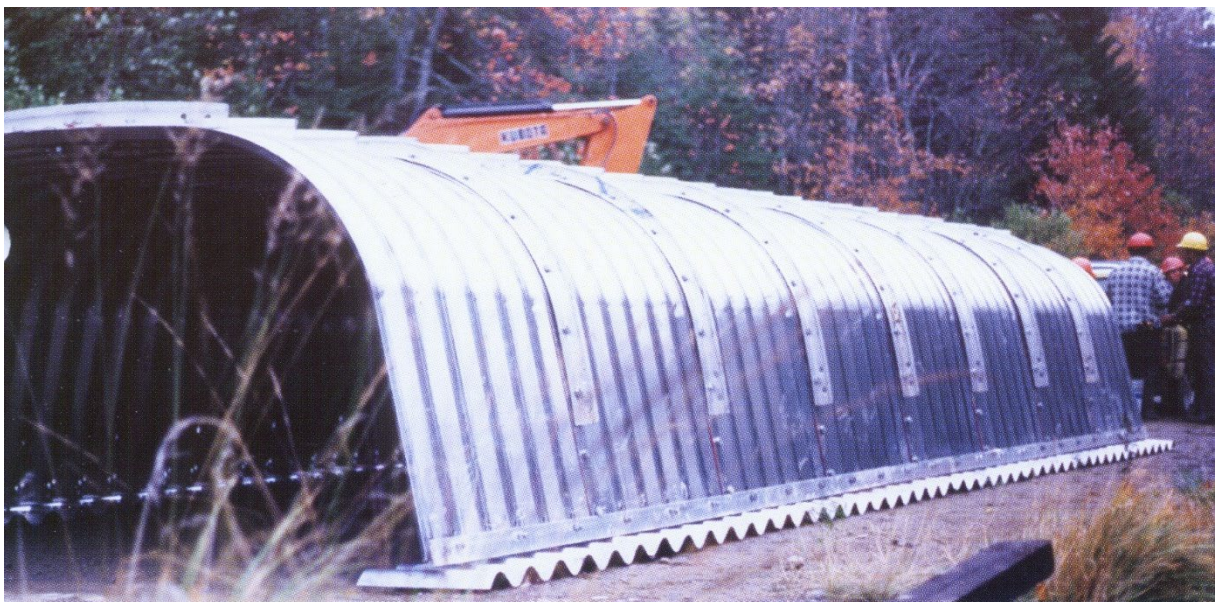
Fotografia 10. Konstrukcja skrzynkowa oparta za pomocą stalowych blach falistych.
