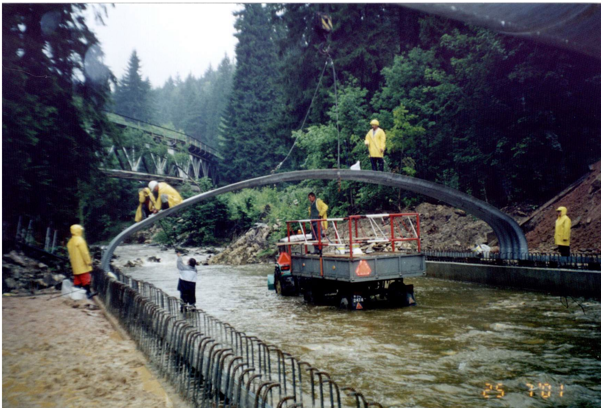
Fotografia 4. Montaż konstrukcji w Polanicy Zdroju.
