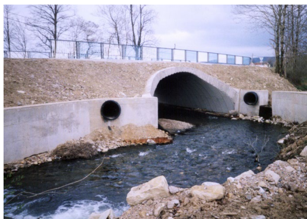
Fot. 3. Widok ukończonego obiektu.
