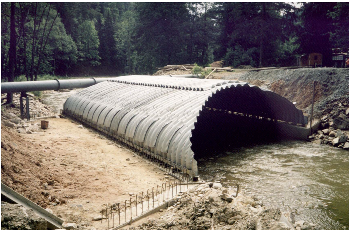
Fotografia 5. Zmontowana konstrukcja w Polanicy Zdroju.
