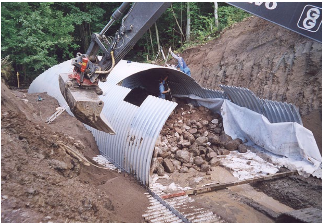
Fotografia 12. Konstrukcja łukowa na fundamencie z blach falistych.
