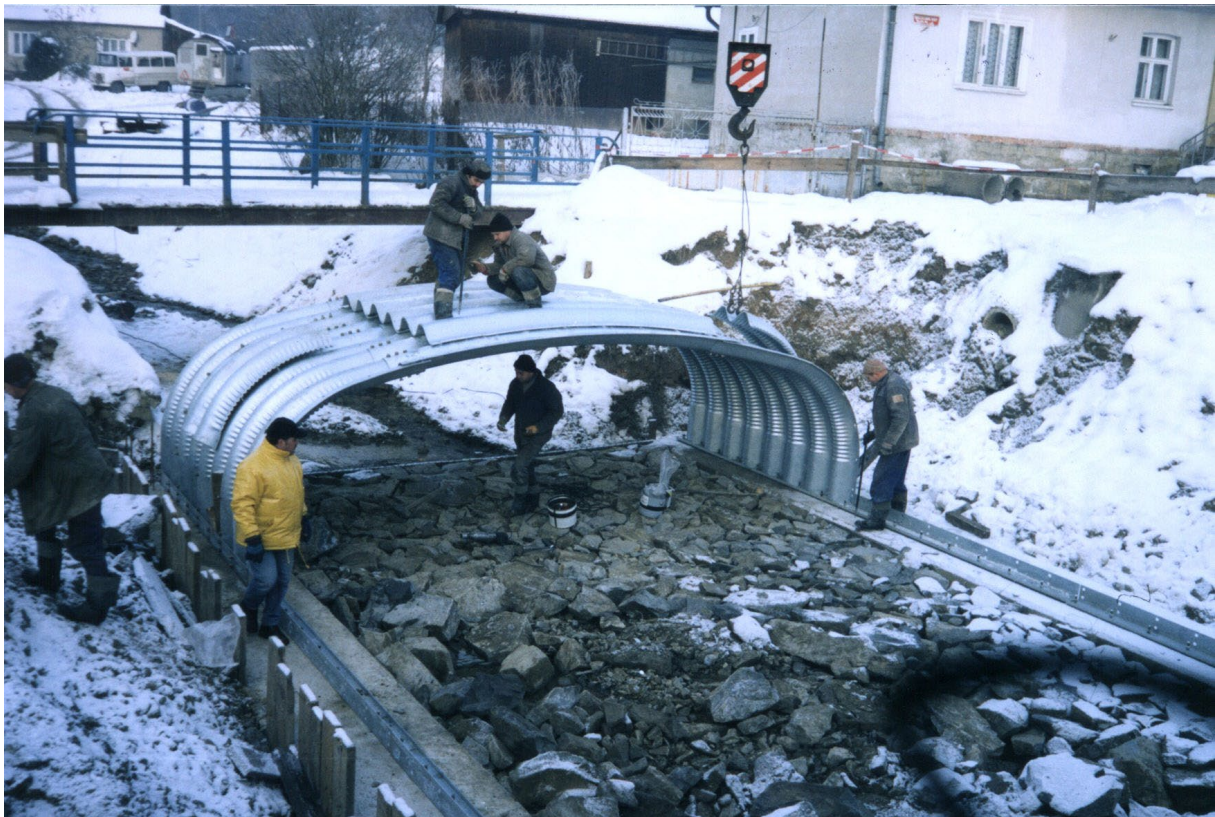
Fotografia 8. Montaż konstrukcji SuperCor SC-20B.
