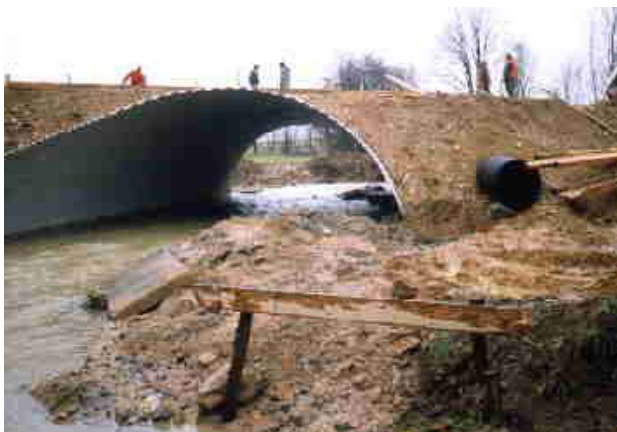
Fot 2. Montaż konstrukcji MultiPlate MP 150 V-45.
