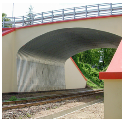
Ściana czołowa żelbetowa – konstrukcja ścięta pionowo.
