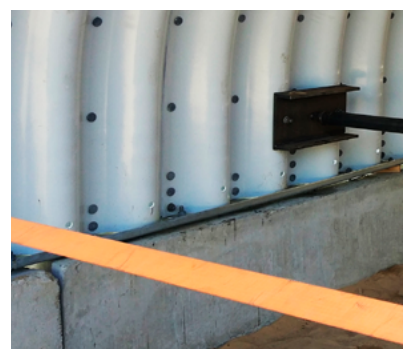
Rys. 7. Połączenie konstrukcji stalowej z fundamentem.
